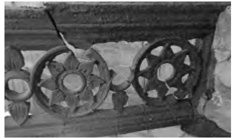
Schadhafter [oben] und restaurierter [unten] Gusseisen-Träger
